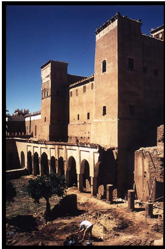
Der Arkadenhof beim Wiederaufbau 1998. Rechts die Rekonstruktion der zerstörten Säulen. Vorn ein Praktikant bei der Herstellung von Lehmziegeln.
