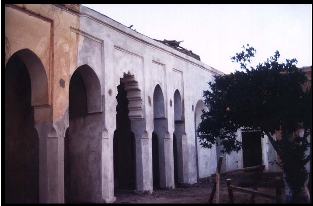
Die im Jahr 2001 fertiggestellten Säulen mit den verzierten Bögen. Es wurde ein kalkvergüteter Lehmputz verwendet, der mit einer Kalkmilch wetterfest gestrichen wurde. Bei diesen Verputzen arbeiteten ausschließlich Lehm- und Stuck-Fachkräfte mit.
