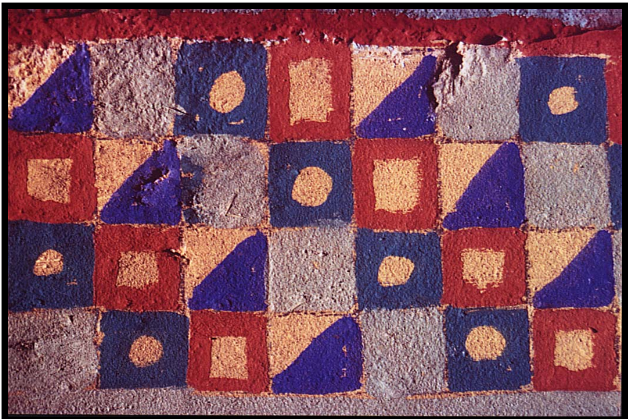
Wandmalereien im Asfallo. Natürliche Farbpigmente mit Leinöl gemischt, ergeben abriebsfeste Anstriche. Die Untergründe sind aus Japan- Putzen, das sind farbige Lehmputze der Firma CLAYTEC/ Viersen hergestellt. Sie sind mit Zellulose gemischt, und dadurch abriebbeständig.
