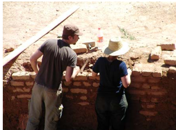
Martin und Anna bei den Reparaturarbeiten
